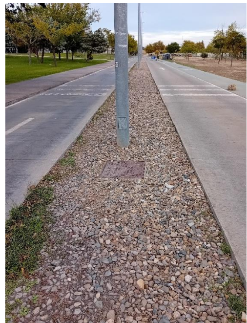
Figura 2. Vial actual en bosque sur sin sistema de recogida de agua de escorrentía
